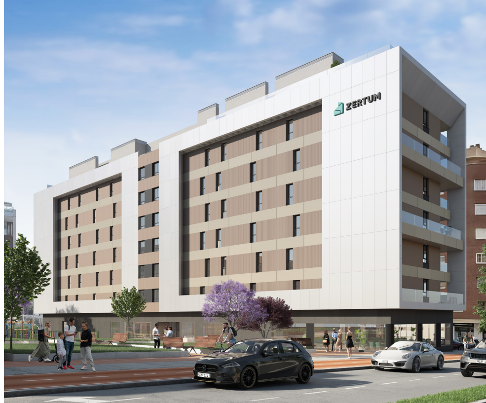
Fachada principal. Calle Marruecos.
