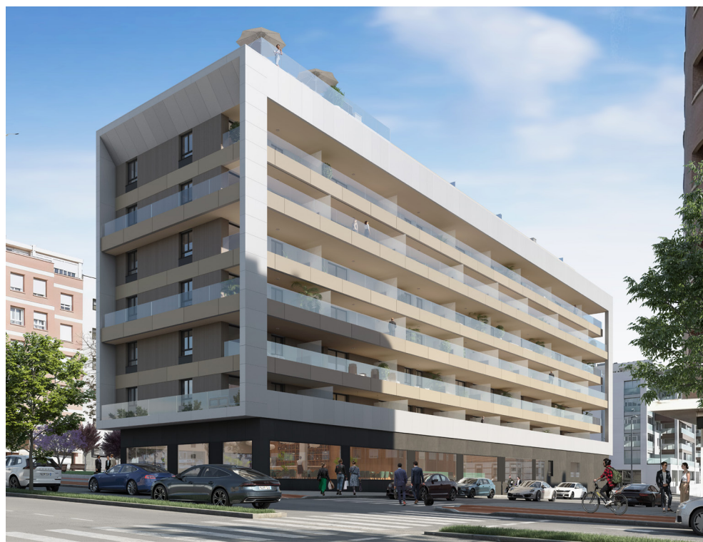
Fachada principal. Confluencia de la Calle Marruecos con Avenida del Mediterraneo .
