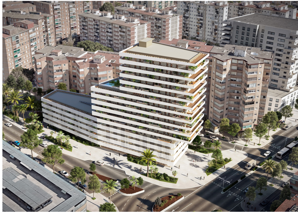
Vista aérea de conjunto. Entorno urbano.
