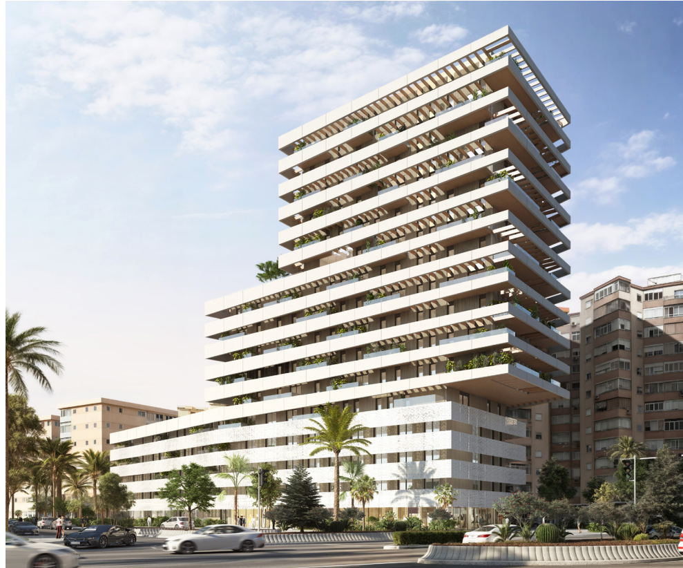
Fachada principal. Confluencia de la Avenida de Velázquez con Avenida de la Luz.
