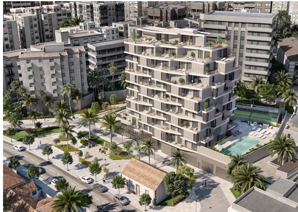
Vista aérea de conjunto. Entorno urbano.
