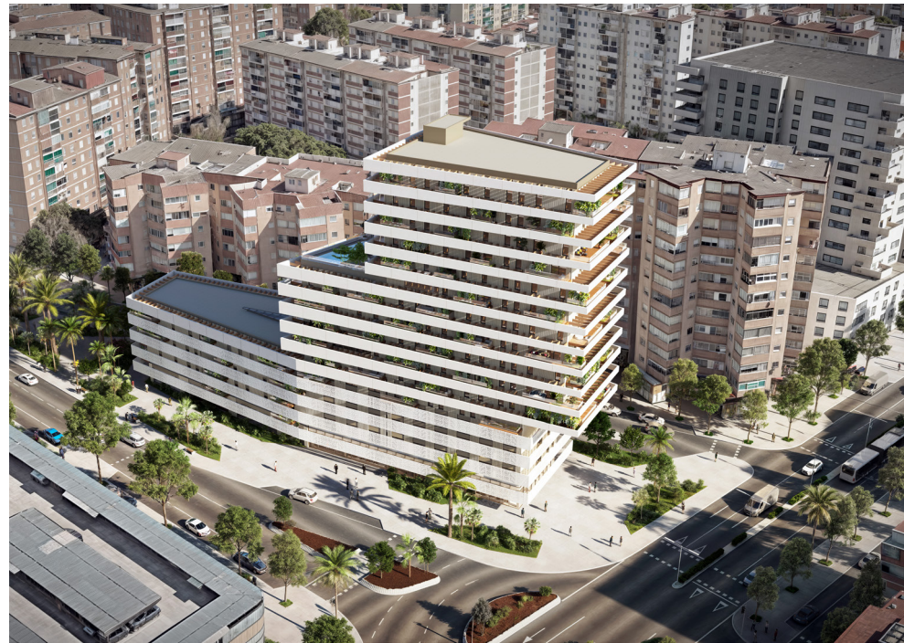
Vista aérea de conjunto. Entorno urbano.
